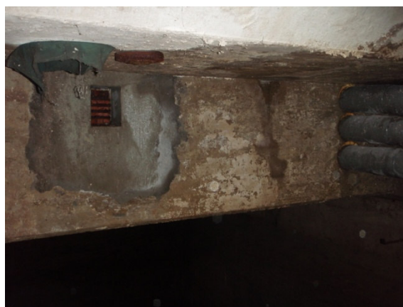
Foto 9: Reparatie in plafondbalk
